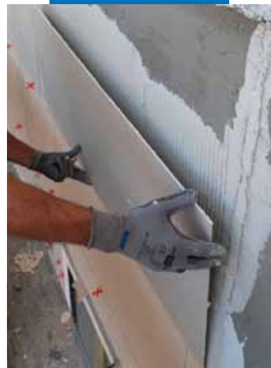
Lepení tenkovrstvého obkladu typu gres na fasádu
