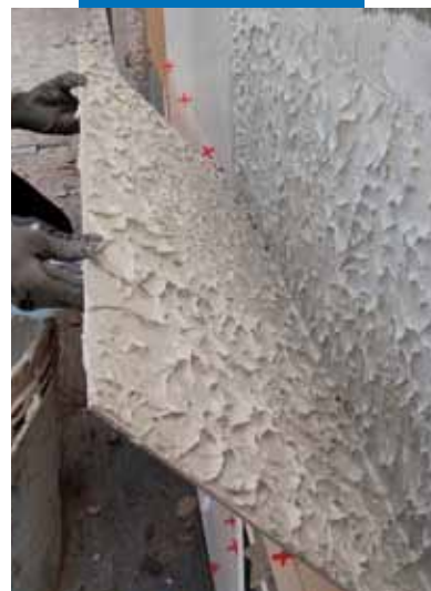
Kontrola pokrytí rubové strany obkladového prvku při lepení na stěnu v exteriéru
